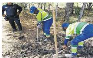
Operativo de inspección a las tuberías del departamento.
